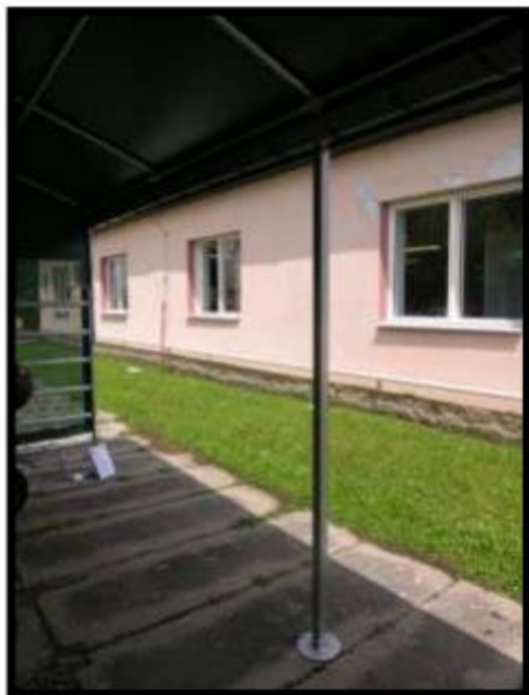
Středový podpěrný sloup- pro lepší využití prostoru jej lze odstranit
