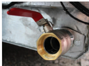
Kulový ventil sběrné nádrže umožňuje jednoduché, bezpečné a hygienické vypouštění kalu.
