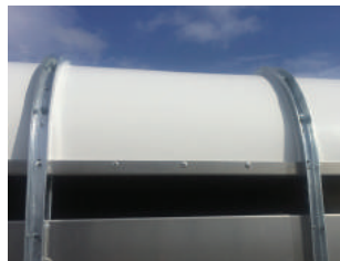
Hliníkové profily vyztužují střechu.
